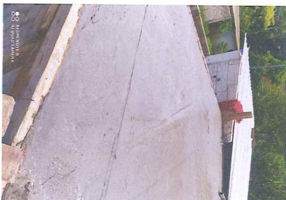
Concepto de obra ejecutado: LOSA PLANA EN SUPER ESTRUCTURA DE 10 CM, DE PERALTE, FABRICADA CON CONCRETO FC=200 KG/CM2, R.N. AGREG. MAX. 20MM, (3/4"), INCLUYE: CIMBRA ACABADO COMUN.
