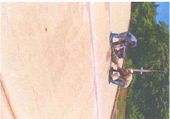
Concepto de obra ejecutado: SUMINISTRO, COLOCACION Y TENDIDO DE CONCRETO HECHO EN OBRA DE 15CM, DE ESPESOR EN ARROYO DE CALLE Y APRICHES, CON RESISTENCIA DE F' C= 250 KG/
