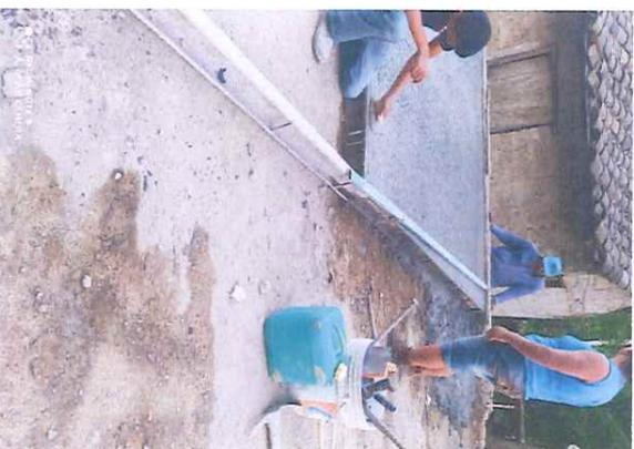
Concepto de obra ejecutado: LOSA PLANA EN SUPER ESTRUCTURA DE 10 CM, DE PERALTE, FABRICADA CON CONCRETO FC=200 KG/CM2, R.N. AGREG. MAX. 20MM. (3/4"), INCLUYE: CIMBRA
