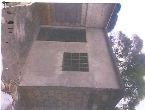
Concepto de obra ejecutado: LOSA PLANA EN SUPER ESTRUCTURA DE 10 CM, DE PERALTE, FABRICADA CON CONCRETO FC=200 KG/CM2, R.N. AGREG. MAX. 20MM, (3/4"), INCLUYE: CIMBRA
