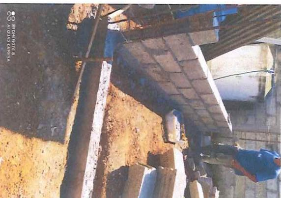
Concepto de obra ejecutado: DALA DESPLANTE SECCION 12X20 CM, CONCRETO FC=200 KG/CM2, R.N. AG. MAX. 3/4", REFORZADA CON ARMEX DE 15X20-4
