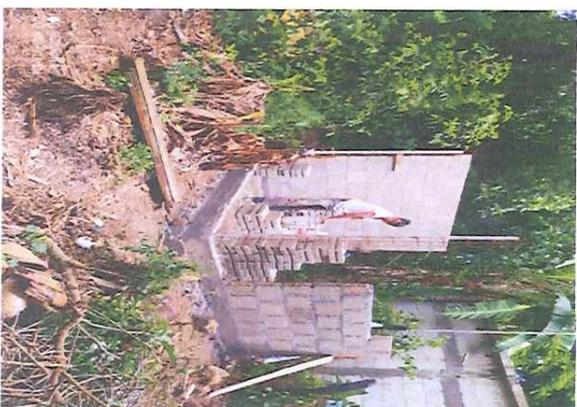
Concepto de obra ejecutado: FABRICACION DE MURO DE BLOCK DE 12x20x40, JUNTEADO CON MORTERO CEM-ARENA 1:5, EN JUNTAS DE HASTA 2.5 CM, CON ACABADO COMÚN
