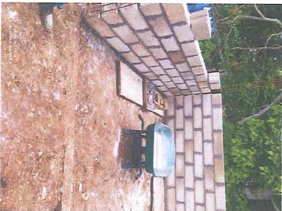
Concepto de obra ejecutado: FABRICACION DE MURO DE BLOCK DE 12x20x40, JUNTEADO CON MORTERO CEM-ARENA 1:5, EN JUNTAS DE HASTA 2.5 CM, CON ACABADO COMÚN
