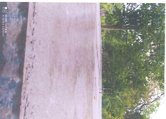
Concepto de obra ejecutado: LOSA PLANA EN SUPER ESTRUCTURA DE 10 CM. DE PERALTE, FABRICADA CON CONCRETO FC=200 KG/CM2, R. N. AGRÉG. MÁX. 20MM, (3/4"), INCLUYE: CIMBRA
