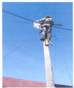
En total de materiales utilizados en el mantenimiento del alumbrado público municipal de Tlacotepec de Mejia ha sido 62 piezas de Fotoceldas, 37 Bases para Fotoceldas, 141 focos o lámparas, 11 cajas de 100 metros de cable de calibre 12 AWG, 12 pieza de luminarias nuevas, 4 contactos, 31 soquets, 2 reflectores y material eléctrico como son cintas de aislar, pelacables, desatornillador, etc.
