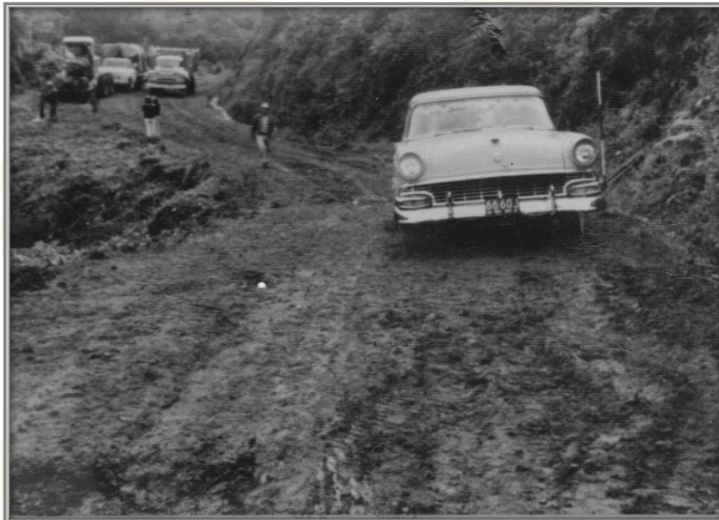
Imagen 002 Construcción de carretera a Tlacotepec de Mejía 1960
